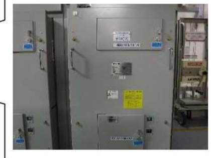
【図2 SA用代替電源受電B系 受電遮断器】
