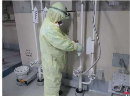
(制御用空気供給弁閉操作イメージ)
