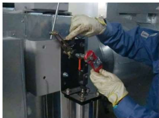
(空気作動ダンパ開作業イメージ)
