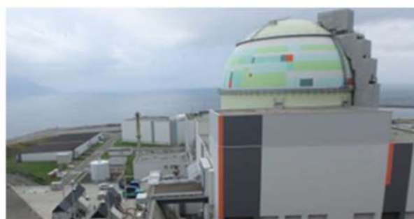
3号炉北東法面
