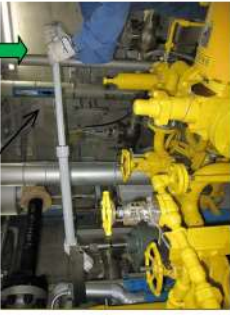
起動レバー (約 10 kg) 押し下げる
