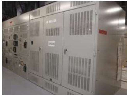
動力変圧器 (パワーコントロールセンタ用)
