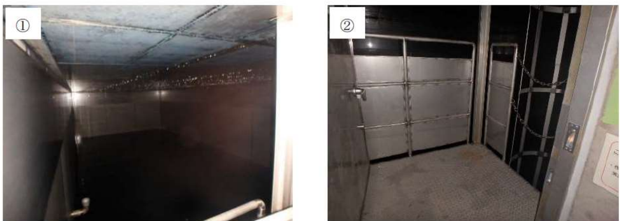
第 5-7 図：補助給水ピットの現場状況
