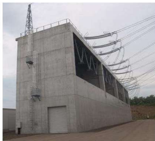
第1図 開閉所（遮風建屋）
