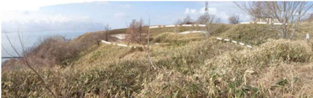
P6 防災科研調査において滑落崖とされる斜面の状況 滑落崖を示唆する遷急線及び遷緩線が認められる。
