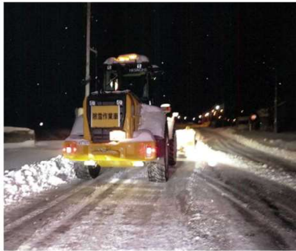
第4-2図 重機による除雪作業（2）
