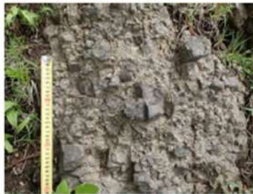
P6 防災科調査において地滑り土塊北側端部とされる箇所付近の露岩状況 堅硬な岩盤(凝灰角礫岩)が認められる。
