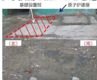
③基礎設置部 (西側)
