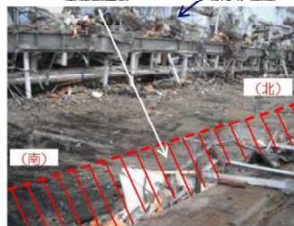
④基礎設置部 (東側、外部)
