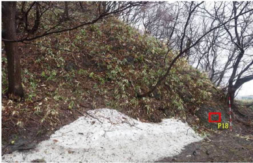
図 2.1.a.c-4 (17) 防潮堤（茶津側）露頭状況 P17 茶津川沿いの地山斜面下部 凝灰角礫岩の露頭が分布する。
