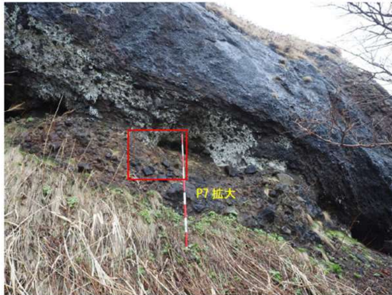
図 2.1. a. c-4 (7) 防潮堤（茶津側）露頭状況 P7 岬の近景（海側）（P6 拡大） 下位が礫径の大きい凝灰角礫岩，上位に小径の凝灰角礫岩が 分布し，B 級からなる。
