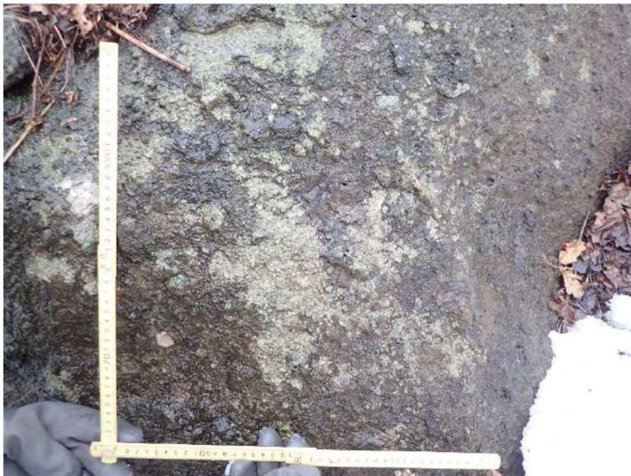
図 2.1.a.c-4 (16) 防潮堤（茶津側）露頭状況 P16 茶津川沿いの地山斜面下部拡大（P15 拡大） 凝灰角礫岩から凝灰岩（火山礫凝灰岩）が分布し，B 級からなる。
