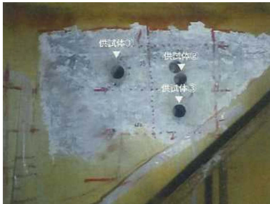
地下階のコア採取状況
