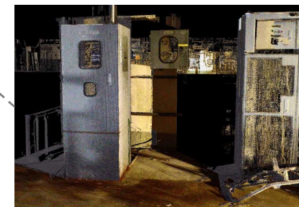
北側シェル壁点群
