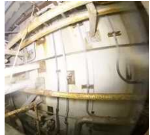
プール壁 (3階西面)
