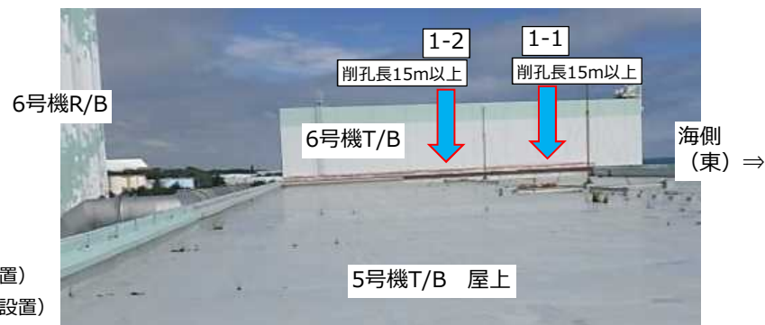
図2 5号機T/B,6号機T/B間 試験施工位置 (5号機T/B屋上から6号機T/Bを撮影)
