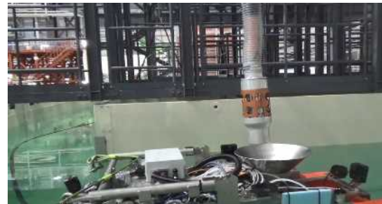
移送ホース (地下階接続作業)
