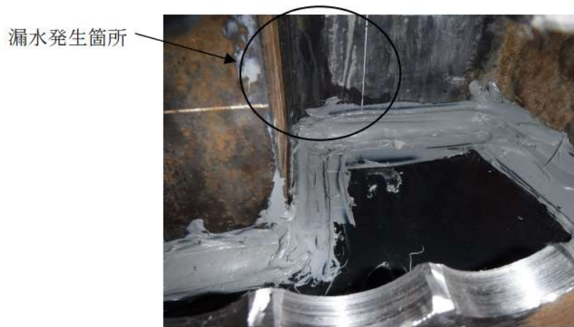
図 26 漏水状況
