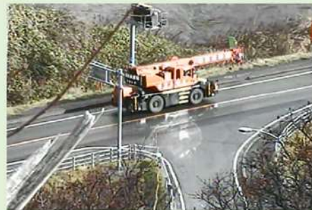
ラフタークレーン車
