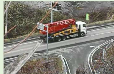
コンクリートポンプ車
