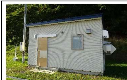
No.19：堀株守衛所待機所
