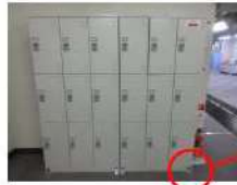
第1図 転倒防止処置例
