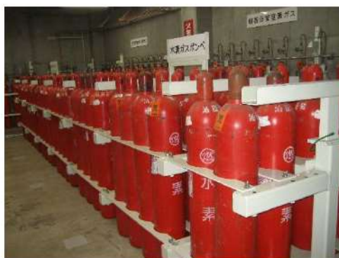
2号炉発電機ガスボンベ庫
