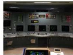
直流照明兼非常用照明点灯時のイメージ (写真：シミュレータ施設)
