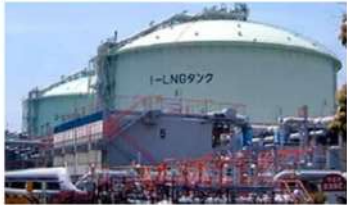
（写真：姫路LNG基地のLNGタンク 当社HPより）
