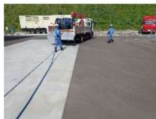
号炉間連絡予備ケーブル敷設（屋外）
