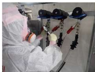
号炉間連絡予備ケーブル接続（端子） （屋外） （作業風景は類似作業）
