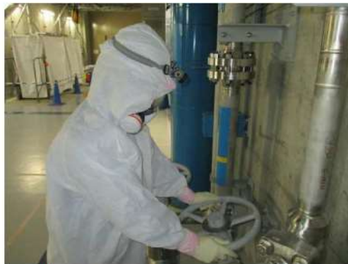
原子炉容器への注水から原子炉格納容器内へのスプレイへの切替え系統構成 (周辺補機棟 T.P. 10.3m)
