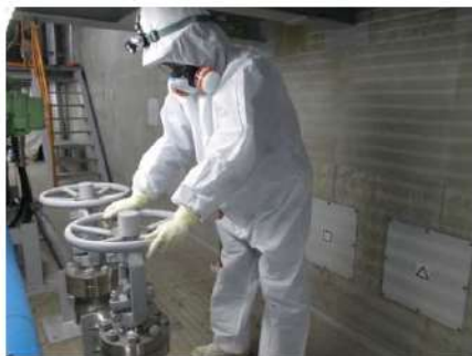
系統構成 （運転員（現場）B） （周辺補機棟 T. P. 29. 3m）
