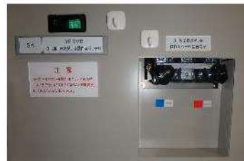
加圧器逃がし弁操作用バッテリー 繋ぎ込み (原子炉補助建屋 T. P. 10. 3m)
