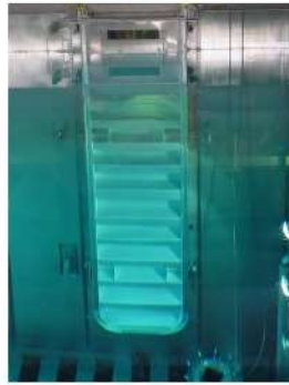
ゲートの設置状況
