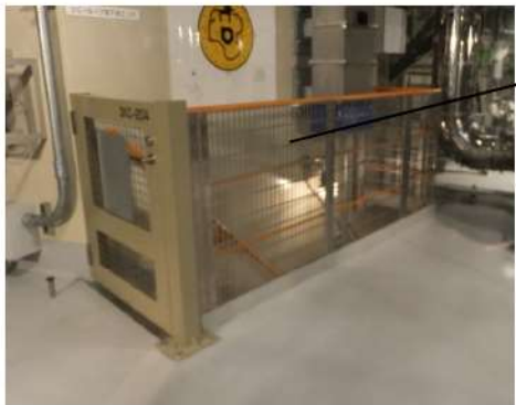
(写真A) 階段開口部に設置したパンチングメタル
