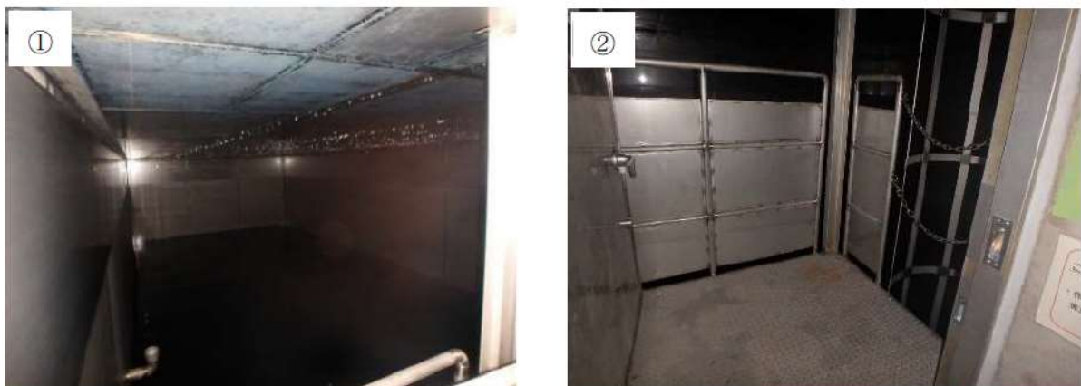
第 41-4-7 図：補助給水ピットの現場状況
