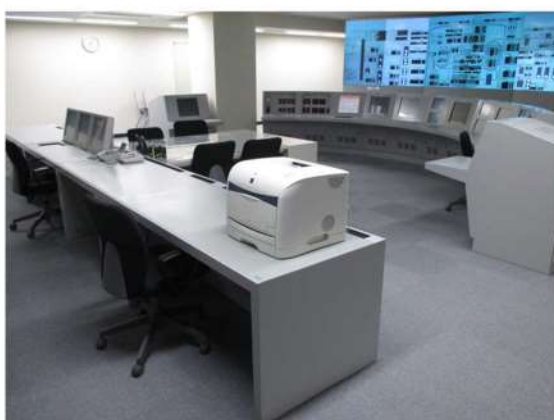
通常点灯時 (運転保安灯及び無停電運転保安灯)
