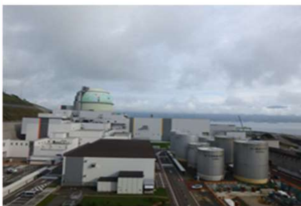
2号炉タービン建屋屋上
