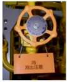
油類に係る弁 弁の識別
