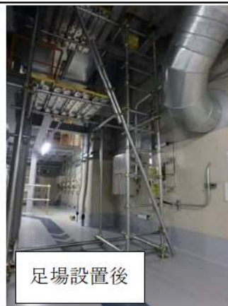
第2.1.2.8 図 アニュラス空気浄化設備における足場設置困難箇所及び足場設置モックアップ実施結果
