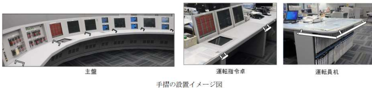
図 2. 4. 2 中央制御室における消火器の設置状況，キャビネット等の固定状況及び手摺の設置イメージ
