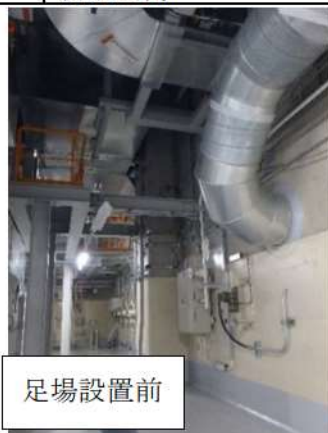
第2.1.2.8 図 アニュラス空気浄化設備における足場設置困難箇所及び足場設置モックアップ実施結果
