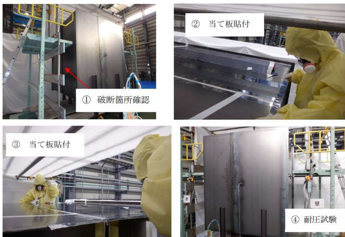
第2.1.2.9 図 当て板による修復作業概要 (モックアップ)
