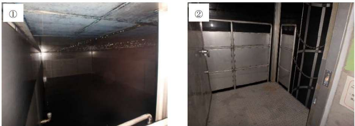
第 5-7 図：補助給水ピットの現場状況
