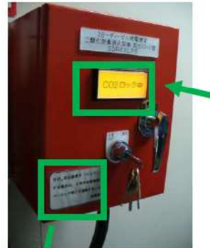
写真③ 放出ロック盤
