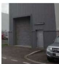
シャッター, 扉
