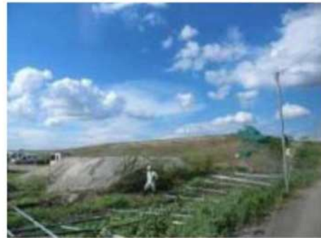
フェンスの被害
