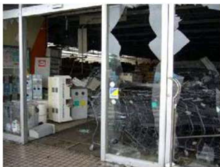
エントランスの窓ガラスの破損
