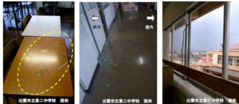
(1) 教室 (2) 廊下 (3) 屋外に面した窓ガラス
