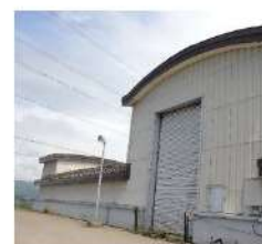
シャッター, 屋根
