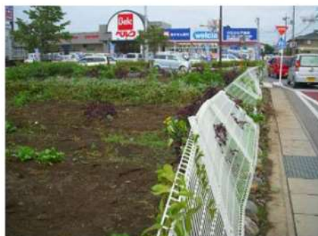
フェンスの変形
