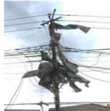
飛散した折板屋根の状況
