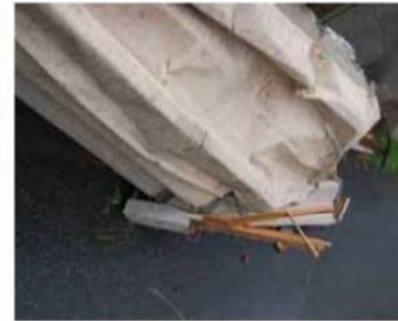
飛散した折板屋根の状況
