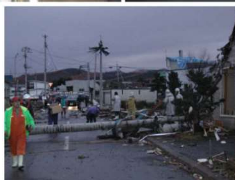
(電柱, 道路標識の折損)
