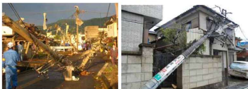
(電柱の折損, 傾斜)
