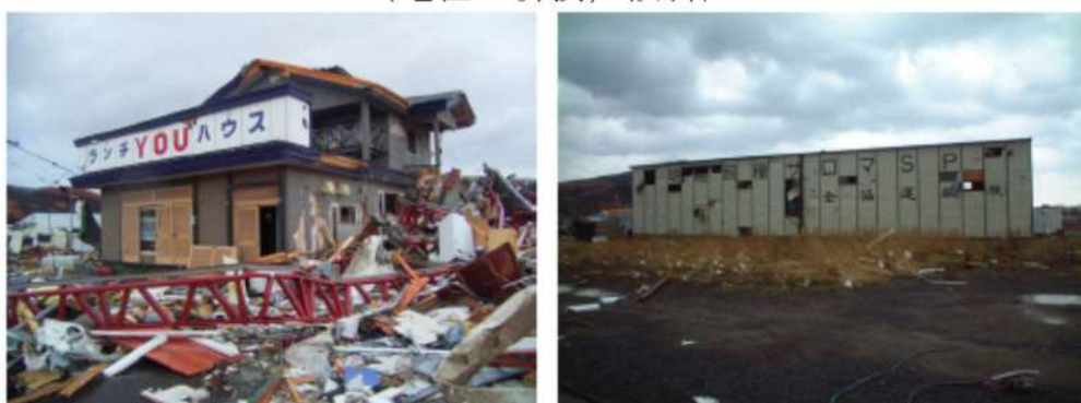
(建築物への飛来物の衝突痕)
