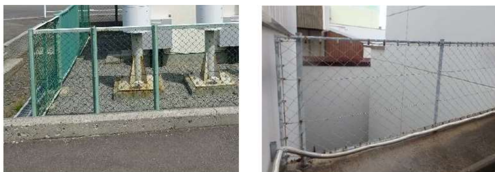
図33 泊発電所におけるフェンスの状況
