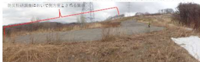
P3 防災科研調査において側方崖とされる斜面の状況 側方崖を示唆する遷急線及び遷緩線は認められない。
