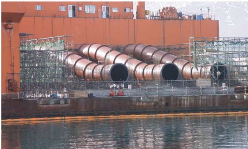
【建設時（曳航前）】鋼製管全景（コンクリート巻き立て前）
