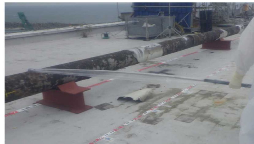
測定状況(配管上面)
