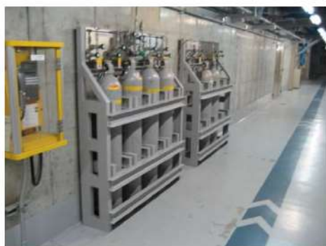
主蒸気逃がし弁操作可搬型空気ポンベ (周辺補機棟 T. P. 10. 3m)
