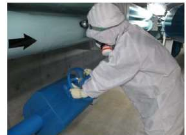
通水操作 (周辺補機棟 T.P. 2.3m)
