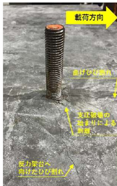
第 7-64 図 せん断試験後の状況写真（せん断 3）
