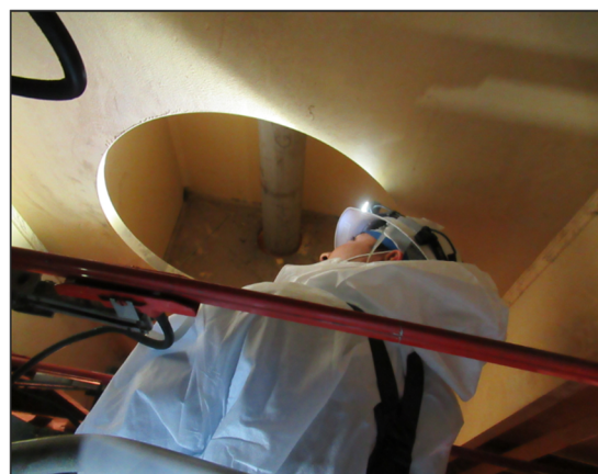
改善後の点検状況（試運用の実施状況）
