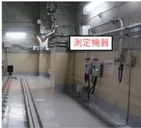
⑦使用済燃料ピット周り
