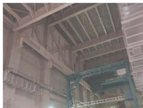
図 5.2.2 燃料取扱棟の屋根
