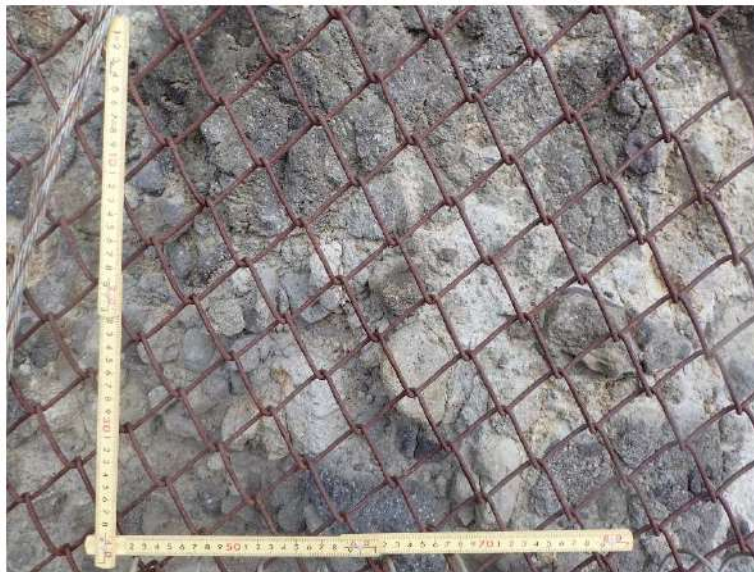
図 2.1.a.c-7 (4) 防潮堤（堀株側）露頭状況 P4 防潮堤擦り付け部周辺（P3 拡大） 凝灰角礫岩が分布し，B 級からなる。
