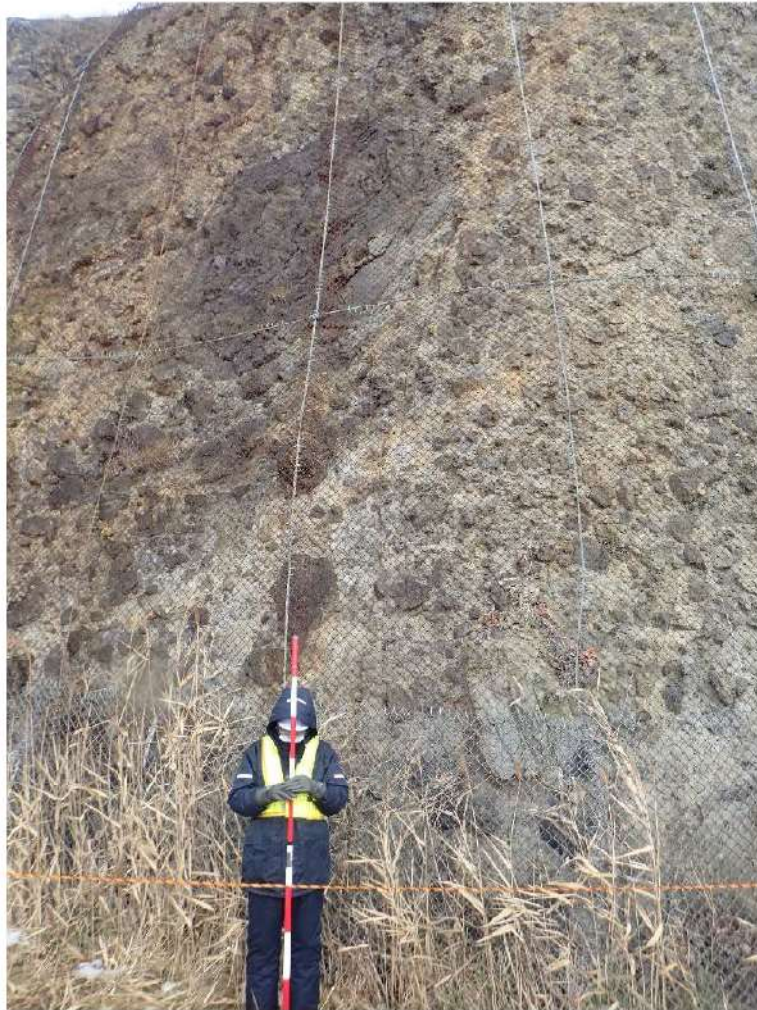
図 2.1.a.c-7 (7) 防潮堤（堀株側）露頭状況 P7 防潮堤擦り付け部周辺（P6 拡大） 凝灰角礫岩が分布し，B 級からなる。
