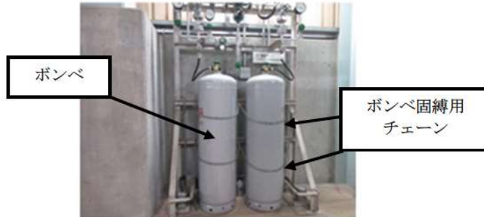
【3号炉補助ボイラー建屋】プロパンガス（補助ボイラー起動用）
