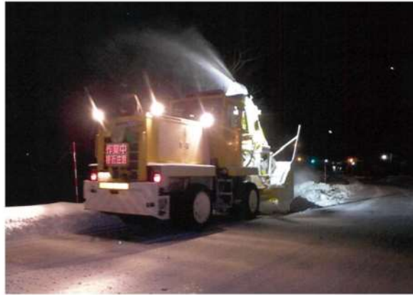
第4-1図 重機による除雪作業（1）
