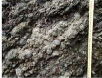
P5 防災科調査において地滑り土塊南側端部とされる箇所付近の露岩状況 堅硬な岩盤(凝灰角礫岩)が認められる。
