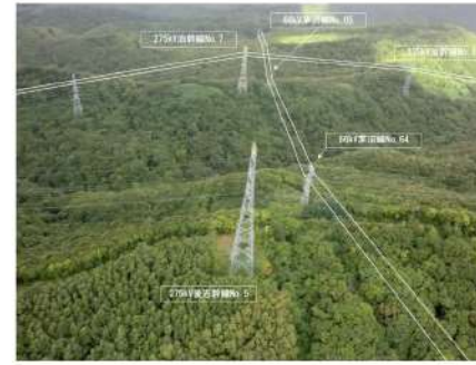
第2.2.3.5図 ③交差箇所の現地状況 (1/3)
