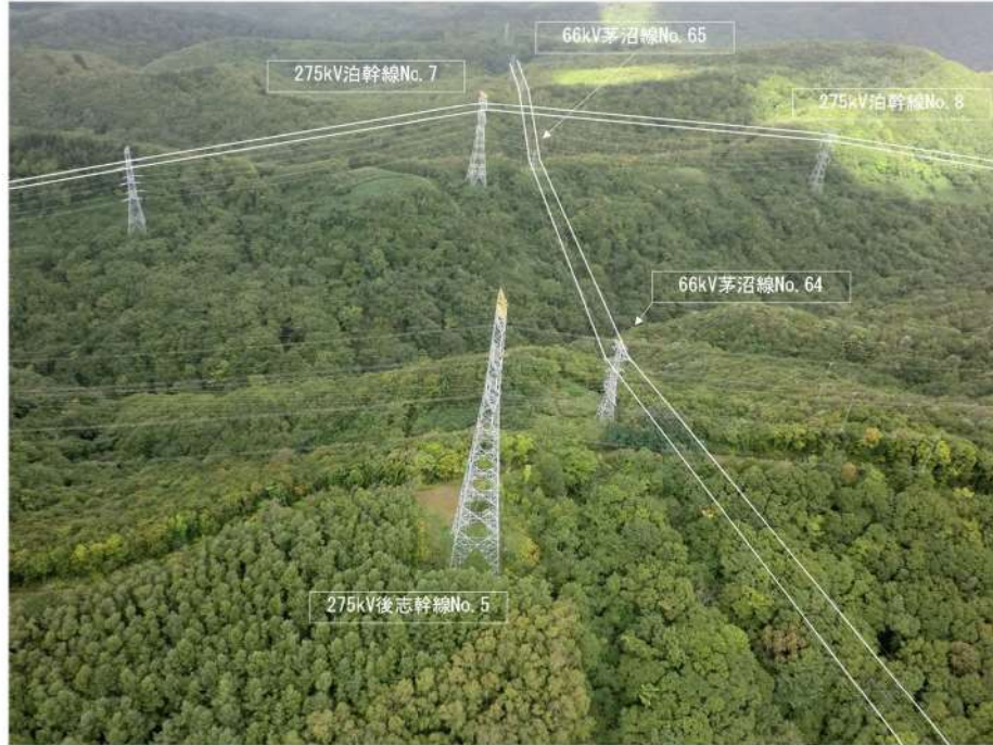
第 2. 2. 3. 5 図 ③交差箇所の現地状況 (1/3)
