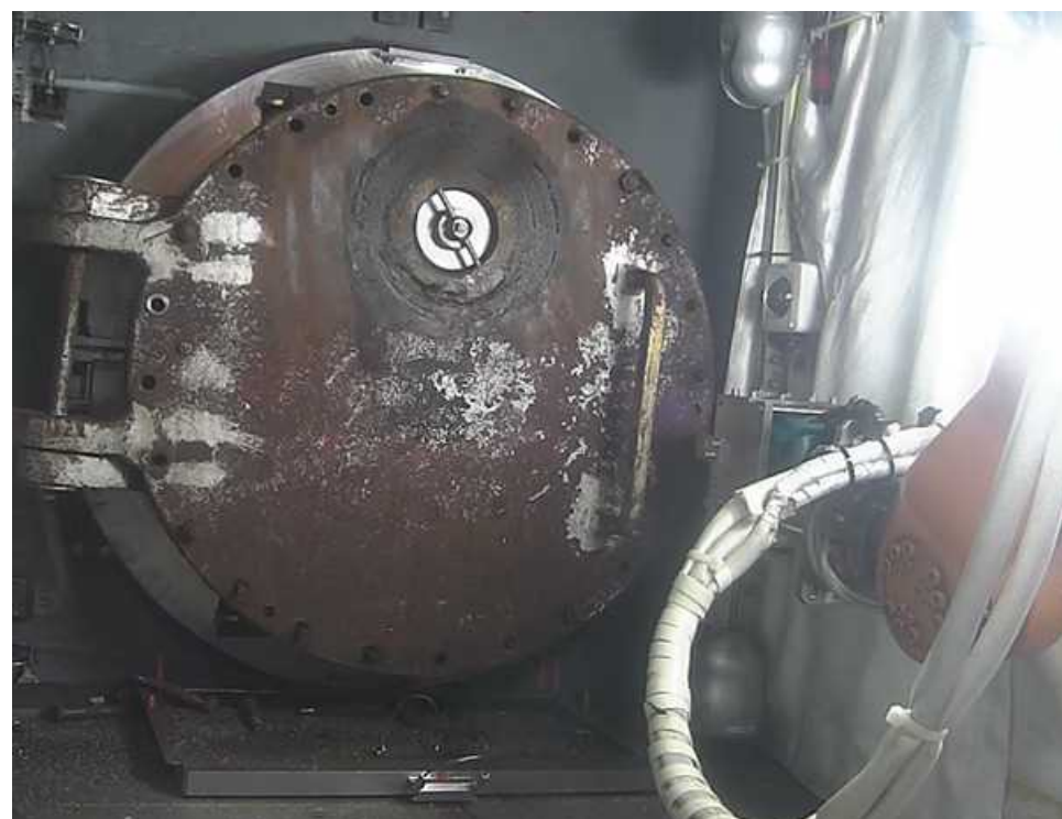
ボルト除去作業状況
