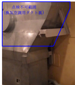
図 5. 1 接近可能だが要領書で定めたデータ採取方法の要求条件が確保できない範囲の例
