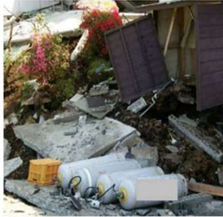
熊本地震でのLPガスボンベの被災状況の一例 3)
