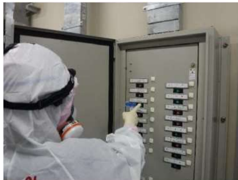
加圧器補助スプレイ弁電源入 (原子炉補助建屋 T.P. 10. 3m)
