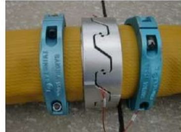
可搬型ホース(150A)接続後
