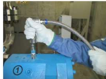
ホース接続操作（軸受側） （周辺補機棟 T. P. 10. 3m）
