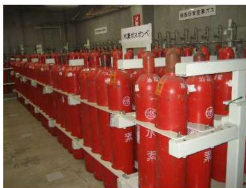
2号炉発電機ガスボンベ庫
