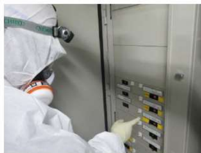
不要直流負荷の切離し操作 (安全補機開閉器室) (原子炉補助建屋T. P. 10. 3m)
