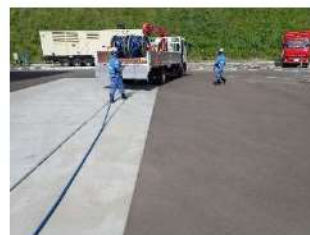
号炉間連絡予備ケーブル敷設（屋外）
