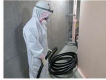
ホース接続(継手接続式)及びホース敷設 (ディーゼル発電機燃料油サービスタンク室) (周辺補機棟T. P. 17. 8m)
