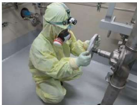
1次系補給水ポンプによる 補給系統構成 (原子炉補助建屋 T. P. 17. 8m)
