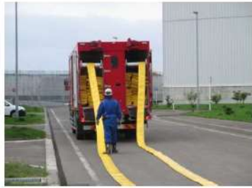
ホース延長・回収車（送水車用）による 可搬型ホース敷設 （屋外）
