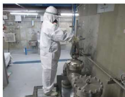
補助給水ピット水源切替 系統構成 (周辺補機棟 T. P. 10.3m)
