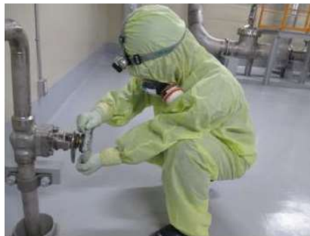
燃料取替用水ピット 補給ライン系統構成 (周辺補機棟 T.P. 10.3m (中間床))
