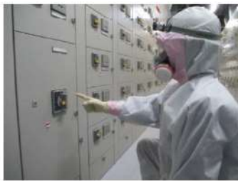
ディーゼル発電機燃料油移送ポンプ 受電準備 (安全補機開閉器室) (原子炉補助建屋T. P. 10. 3m)
