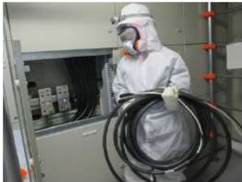
可搬型直流変換器 直流出力ケーブル敷設 (安全補機開閉器室) (原子炉補助建屋T. P. 10. 3m)
