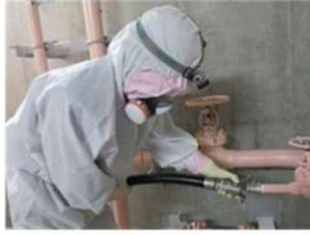
ホース接続(継手接続式)及びホース敷設 (ディーゼル発電機燃料油サービスタンク室) (周辺補機棟T. P. 17. 8m)
