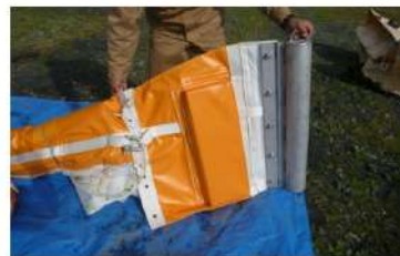
荷揚場シルトフェンス端部
