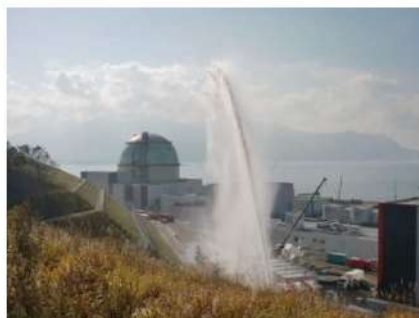
第2図 直線状放射による放水状況
