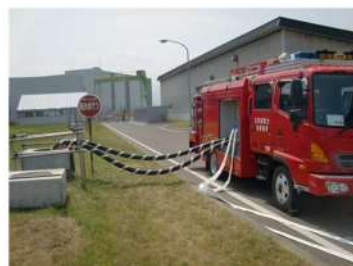
水源への吸管挿入 (屋外)
