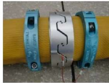
可搬型ホース（150A）接続後
