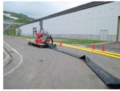
放水砲設置 (屋外)
