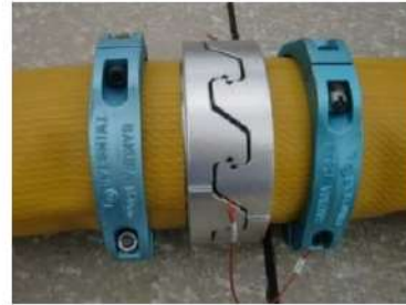
可搬型ホース（150A）接続後
